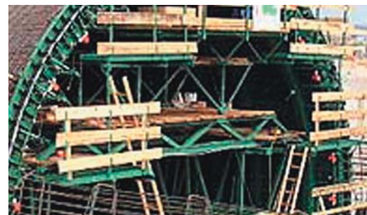
Trillen van tunnelbekisting
