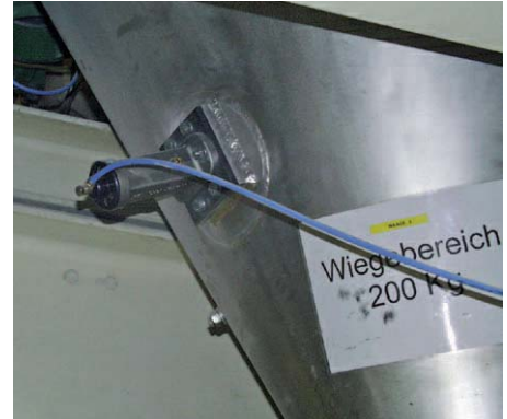
Het verwijderen van restanten in weegbunkers
